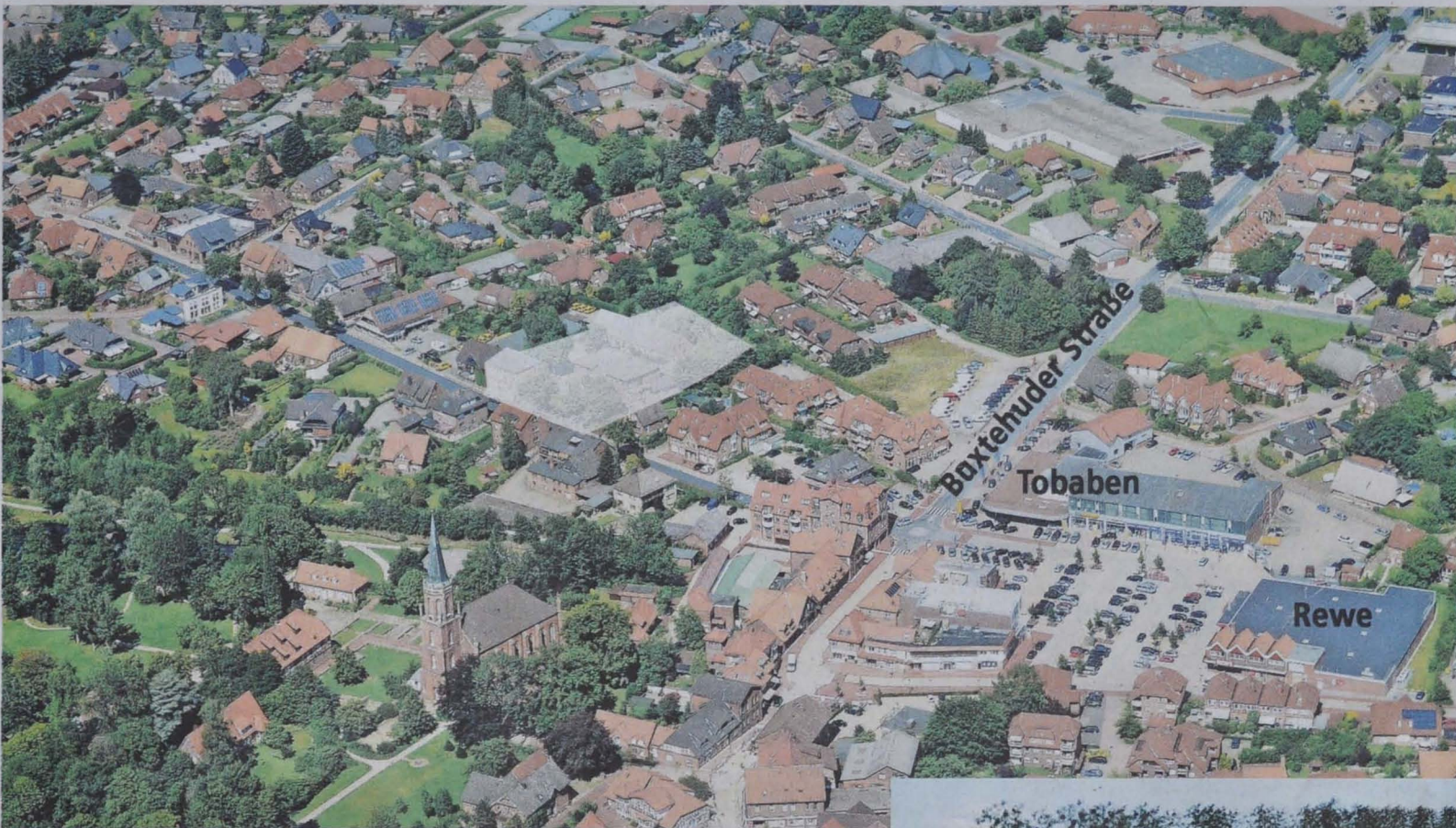
Auf dem Grundstück in der Schulstraße (helle Fläche) wollen die Rotenburger Werke ihr Wohnprojekt für Menschen mit Behinderungen umsetzen. Es ist zentral nahe des Ortszentrums gelegen.
